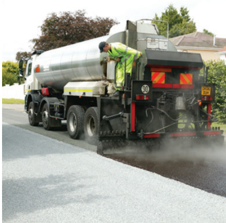
Overflatebehandling med bitumen-emulsjoner.
