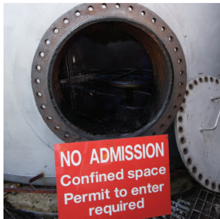
Rengjøring av tank pågår.
