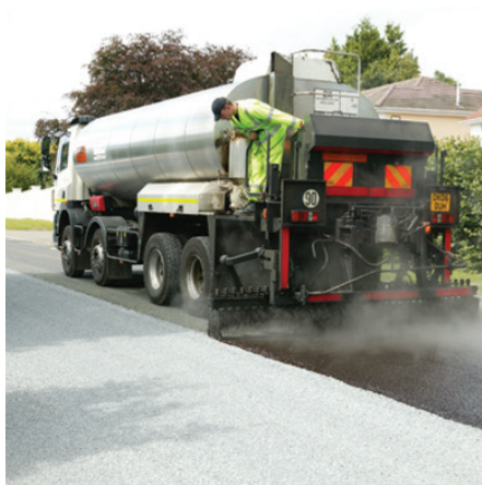
Pinnatöötlus bituumenemulsiooniga
