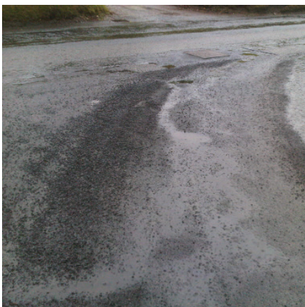
Teekahjustus, mille puhul on tõenäoliseks defektide põhjuseks halvasti segatud asfalt.
